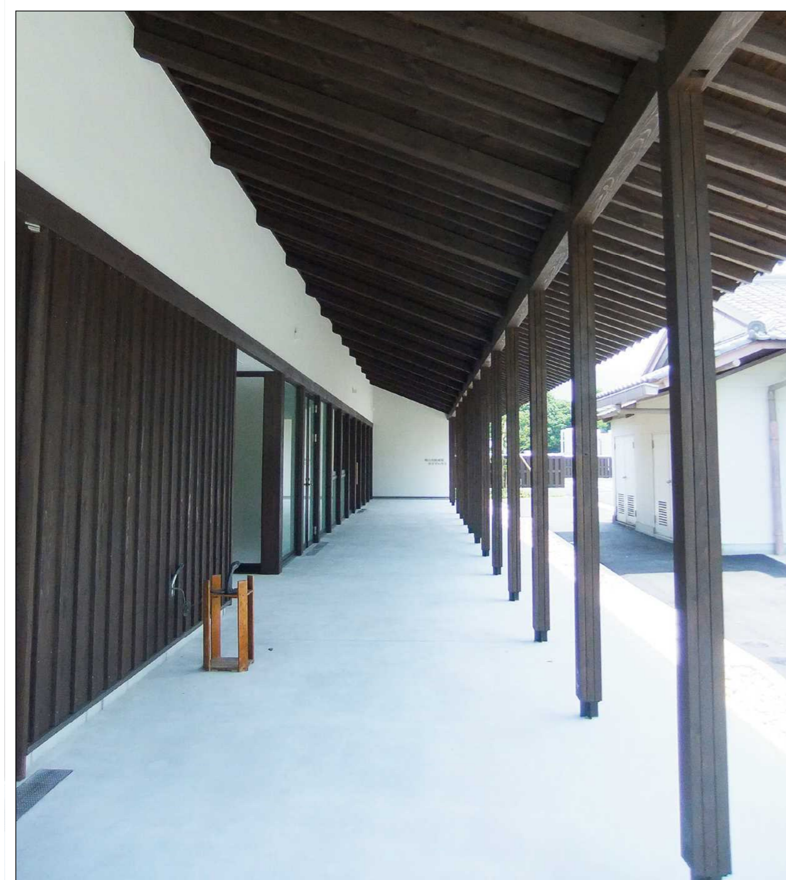
■公共物件 外部化粧柱 (ピン工法)
